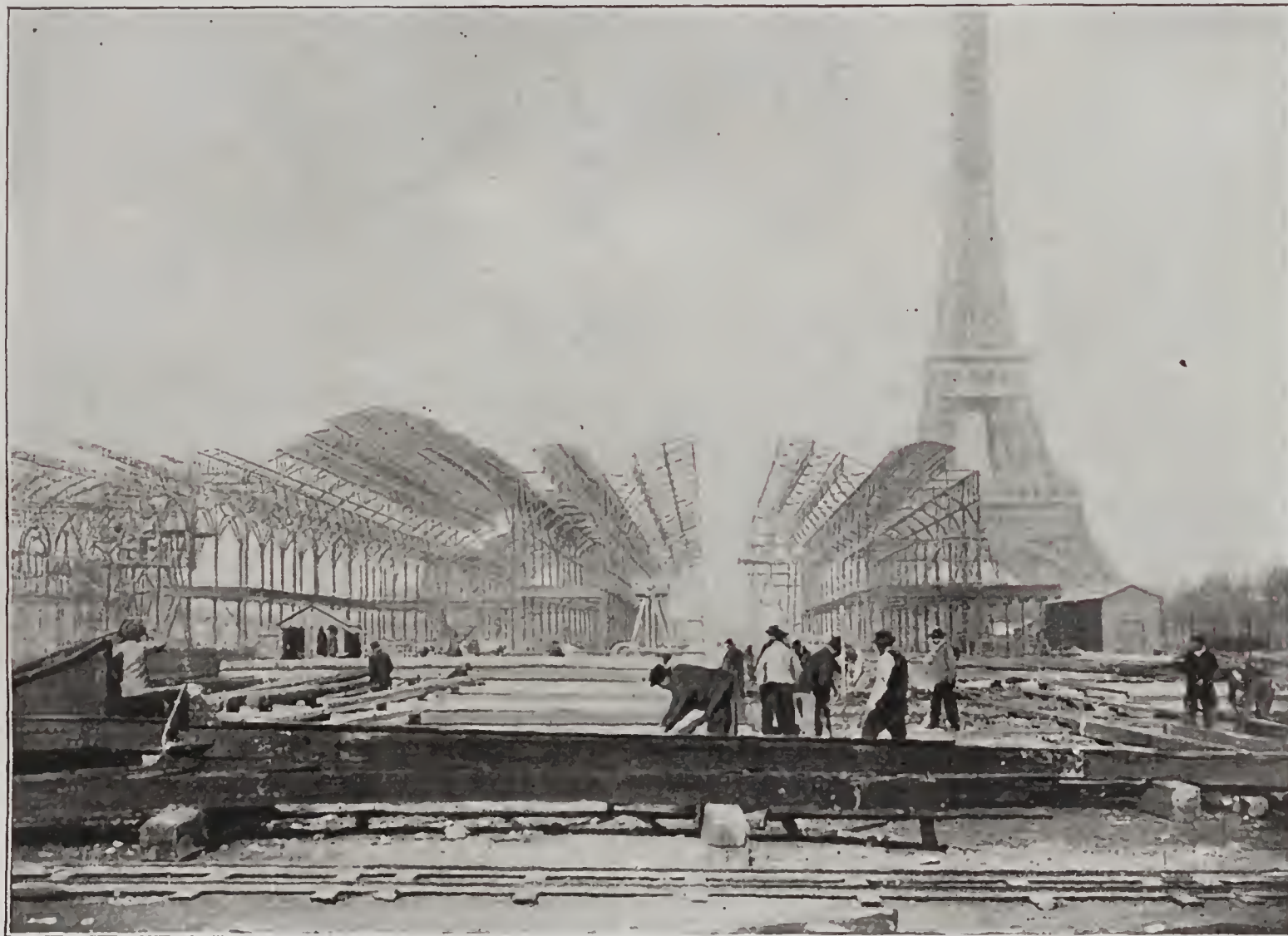
LES CHARPENTES EN FER. — Les fermes au Palais du Génie Civil et des Transports, au Champ-de-Mars.
